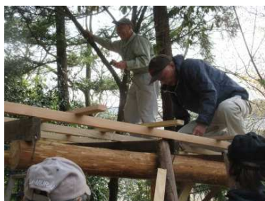
3. 屋根の垂木打ち
