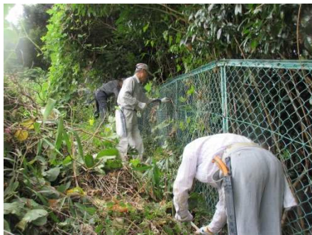
フェンス沿いの整備
