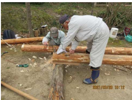
休憩所の屋根づくり 1
