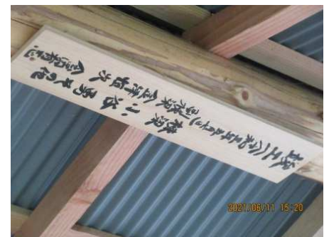
休憩所屋根裏に棟札取り付ける
