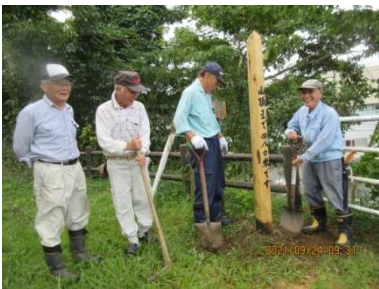
← 標柱設置作業
