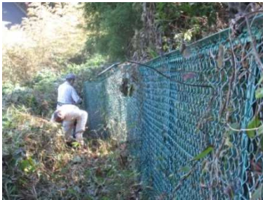
フェンス沿いの整備
