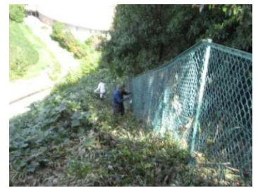
フェンスの沿いの整備
